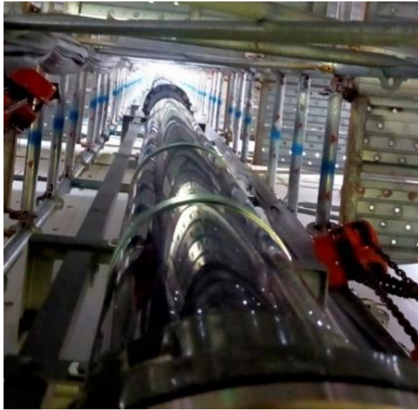
模擬ボーリング孔 (下から見上げた様子)
