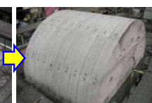
上半緩衝材ブロックを組み上げたところ。
