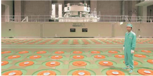
日本原燃(株) 高レベル放射性廃棄物貯蔵管理センター(青森県六ヶ所村) 写真提供:日本原燃(株)
