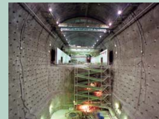
東京電力神流川発電所 (建設時の様子) 写真提供: 東京電力株式会社
