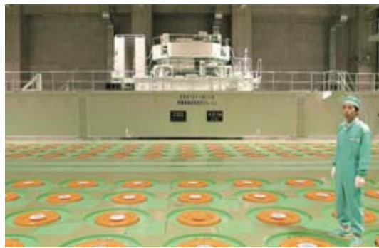
高レベル放射性廃棄物貯蔵施設の貯蔵ピット (※青森県六ヶ所村の高レベル放射性廃棄物貯蔵管理センターの例) 写真提供：日本原燃株式会社
