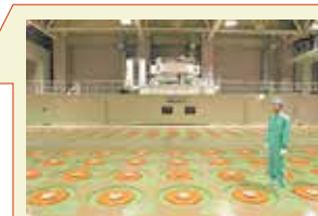
▲約2mのコンクリートで十分に遮蔽が可能です（人間が軽装で立入可能）
