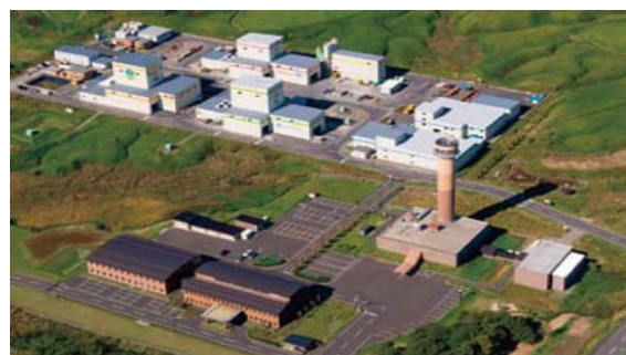
幌延深地層研究センター
