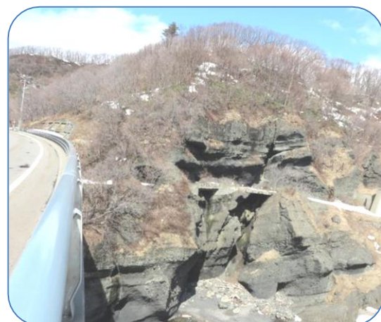
折石大橋周辺
