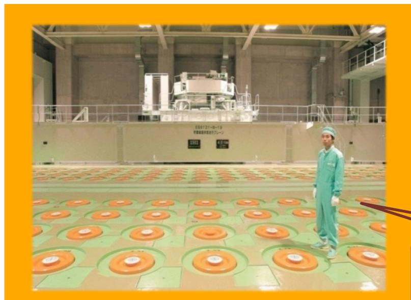
ガラス固化体からは強い放射線が出るが、約2mのコンクリートで十分遮蔽できる。
