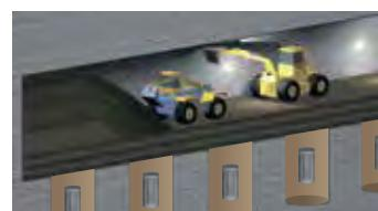
※地上でガラス固化体、オーバーパック、緩衝材を専用の容器(PEM(Prefabricated Engineered Barrier Module)容器)に入れ、それを地下に「横置き」に定置する方法も検討されています。
