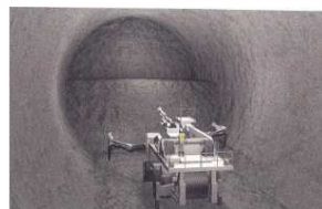
坑道の掘削イメージ
