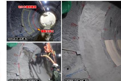
閉鎖性能の向上のための止水プラグの構築
