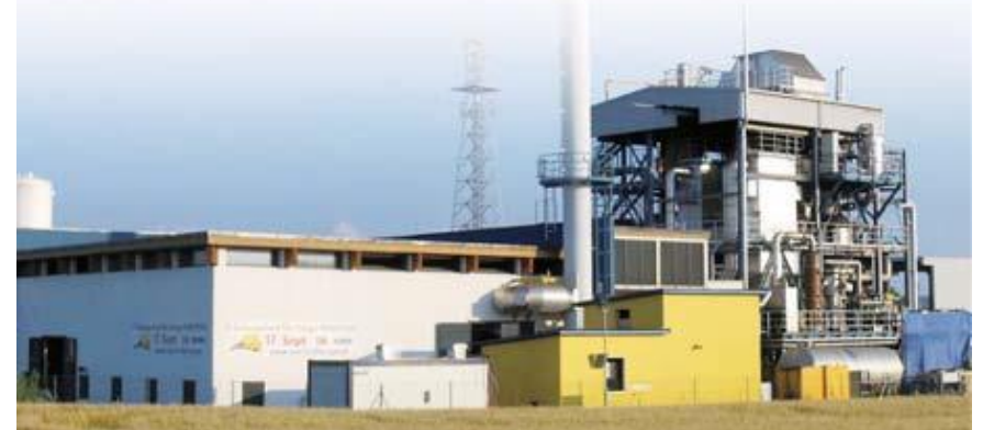
木材ガス化プラント
