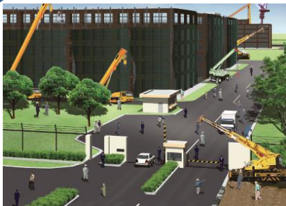
建設中のイメージ
