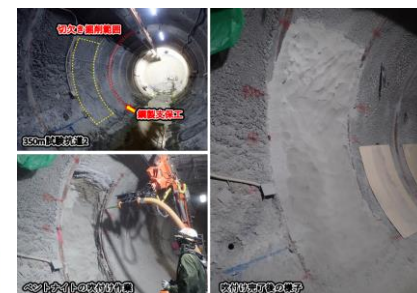
閉鎖性能の向上のための止水プラグの構築
