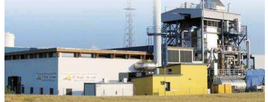
木材ガス化プラント
