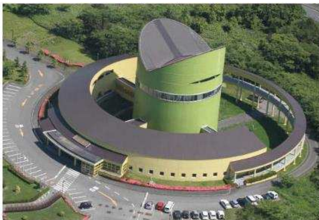
六ヶ所原燃PRセンター 外観
