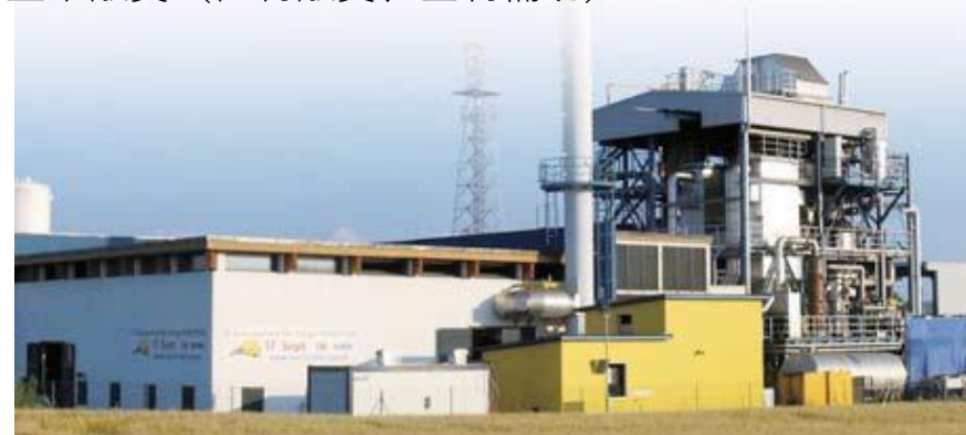
木材ガス化プラント
