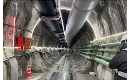
TBMが掘削したトンネルを視察
