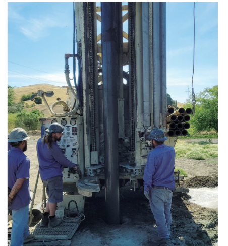
ボーリング孔掘削の作業風景
