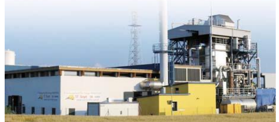
木材ガス化プラント
