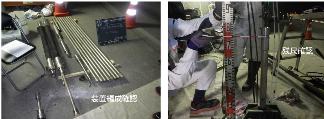
図 6.3.1-2 装置編成及び残尺の確認状況
