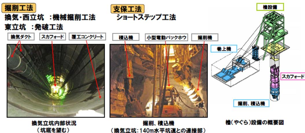
図 6-5 ショートステップ工法による立坑の掘削（出典：JAEA, 2008）
