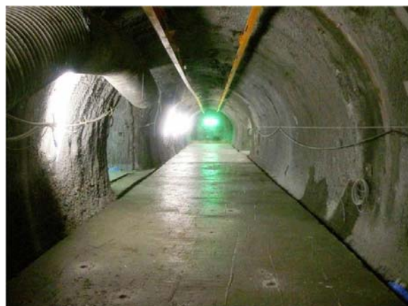
(b) HFSC 施工後の坑内状況
