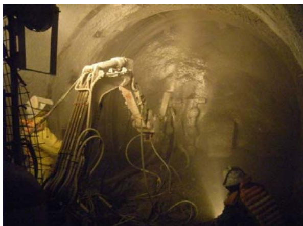
(a) 地下での HFSC 吹きつけ施工の様子
