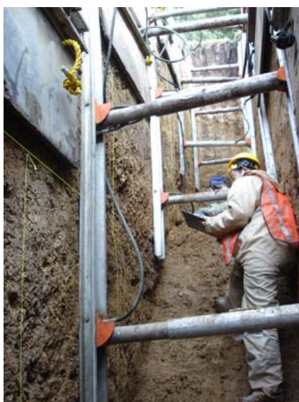
(a) 断層の地表付近の分布・性状を把握するためのトレンチ調査（トレンチ壁面の観察の様子）
