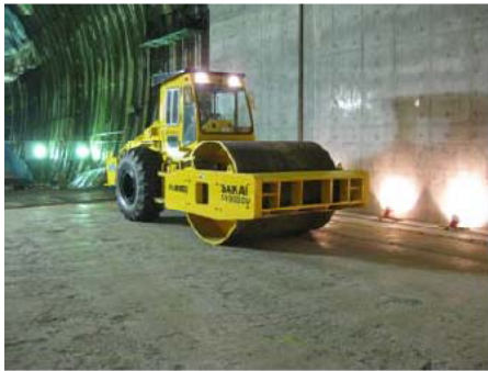
大型振動ローラーによる底部緩衝材の 締固め施工試験
