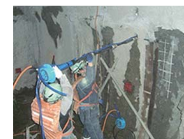
変位計設置の様子
