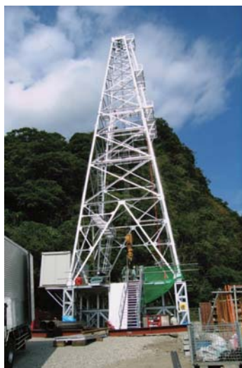
◀ ボーリング調査現場
