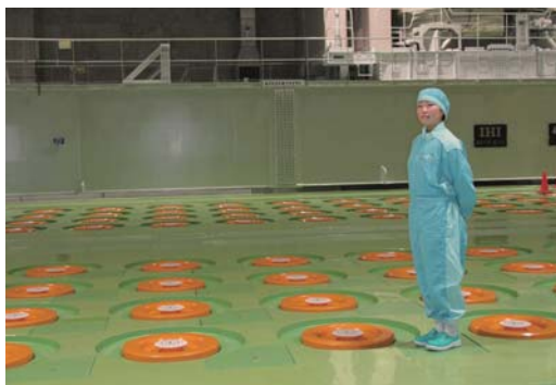
▲ 高レベル放射性廃棄物貯蔵施設の貯蔵ピット (写真提供：日本原燃株式会社)
