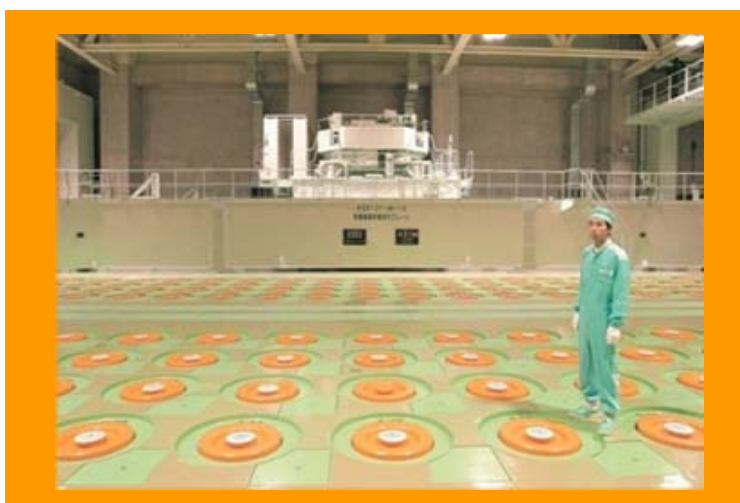
高レベル放射性廃棄物貯蔵施設の貯蔵ピット（写真提供：日本原燃（株））
