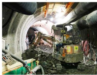
地下研における水平坑道の建設 (JAEA, 2013)
