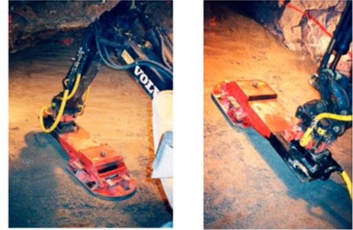
横（斜め）締固め工法による坑道の埋め戻し (SKB, 2001)
