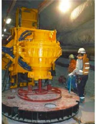
地下研における模擬処分孔の掘削 (JAEA, 2014)
