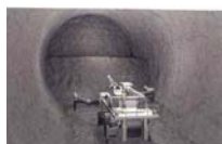
坑道の掘削イメージ
