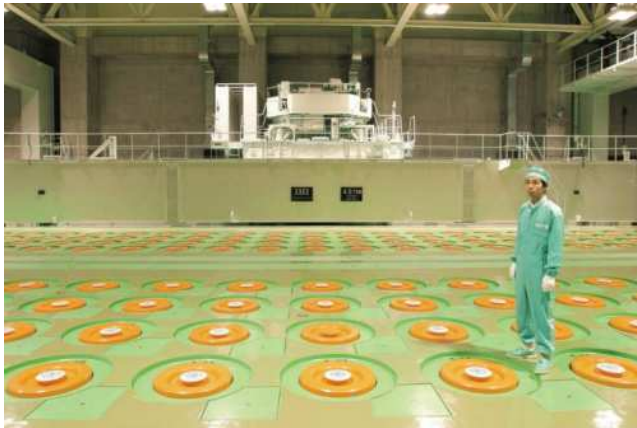
高レベル放射性廃棄物 貯蔵管理センター (青森県六ヶ所村)
