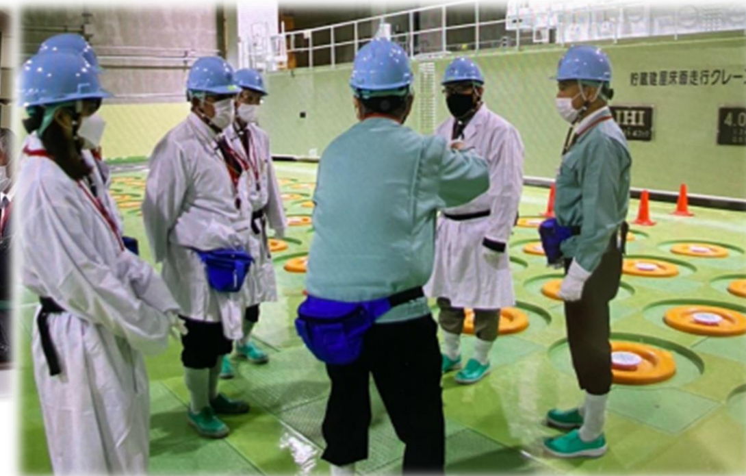
高レベル放射性廃棄物貯蔵管理センターの建屋内部
