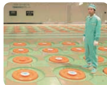
▶貯蔵ピット：厚さ約2mのコンクリート製の床の下にガラス固化体を保管している（青森県六ヶ所村にある高レベル放射性廃棄物貯蔵管理センター）
