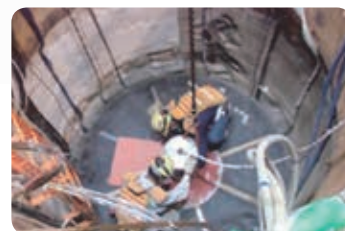
▶ 模擬の人工バリアの試験 (幌延深地層研究センター)
