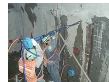
変位計設置の様子
