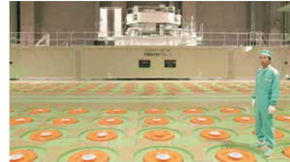
日本原燃(株) 高レベル放射性廃棄物貯蔵管理センター(青森県六ヶ所村) 写真提供: 日本原燃(株)
