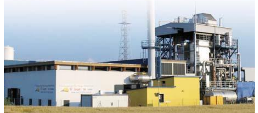
木材ガス化プラント
