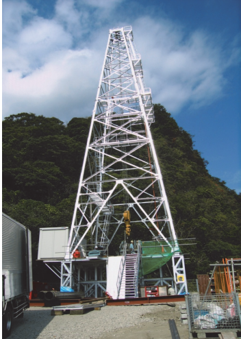
ボーリング調査の外観(やぐら)
