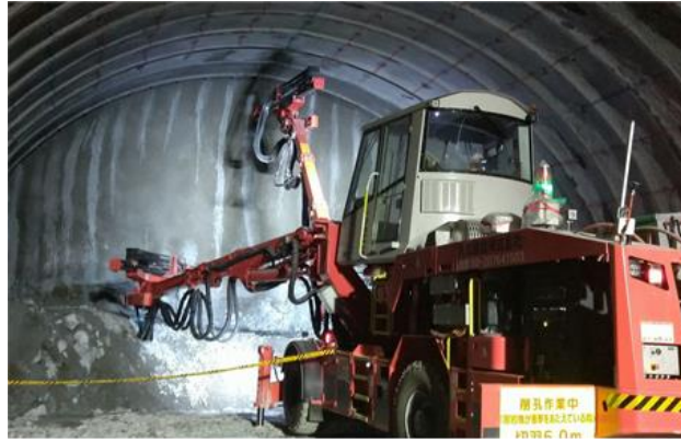
図 1 全自動化されたドリルジャンボによるトンネル切羽における穿孔作業
