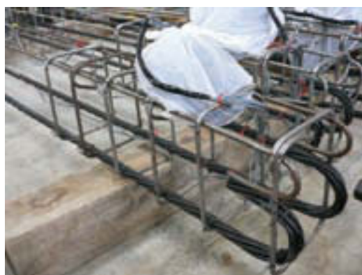
図 2.3-12 炭素繊維複合材ケーブルを用いた補強筋組み立て状況（下段が当該材料）
