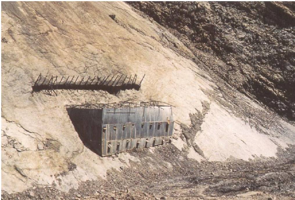
最後に残っているオクロの原子炉領域を覆うコンクリートの石棺 (John Smellie, Conterra)
