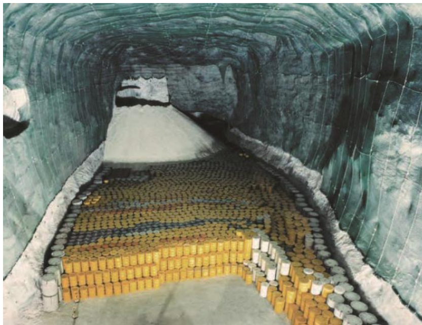
岩塩内にあるドイツ、モルスレーベン地層処分施設に定置された低レベル放射性廃棄物 ( www.kernenergie.de )
