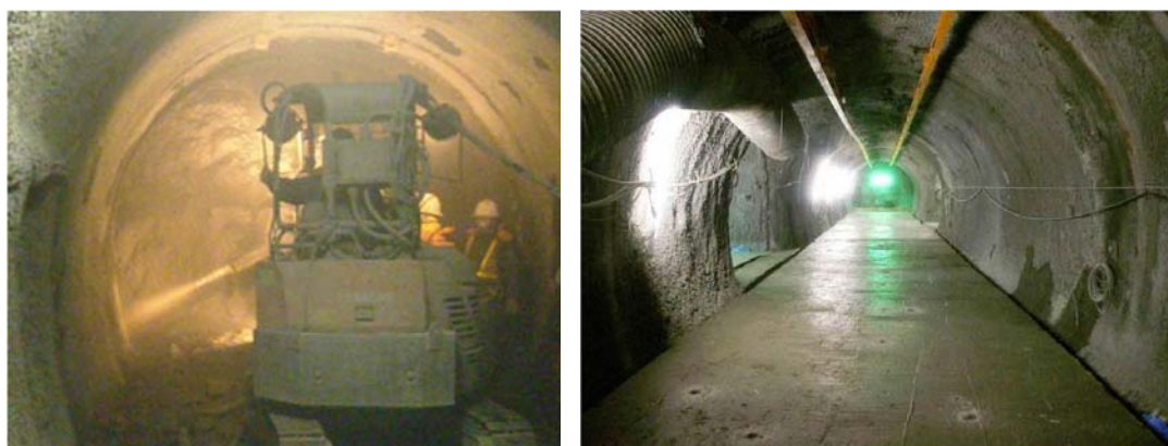
(a) 地下での HFSC 吹付施工の様子
