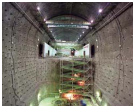
図 6.4.1-7 大空洞の建設時の様子 （写真提供：東京電力株式会社）
