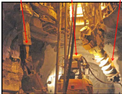
掘削、積込機 (換気立坑：140m水平坑道との接続部)
