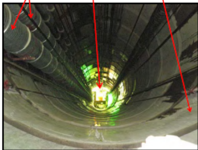
換気立坑内部状況 (坑底を望む)
