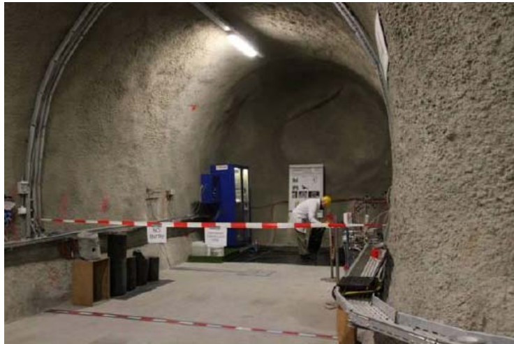
図 2-7 トレーサー試験の準備風景 (Mont Terri project, 2011)
