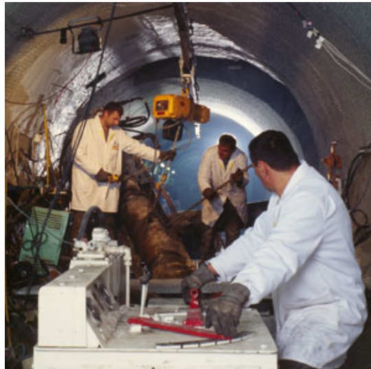
図 2-9 オーバーコアリングの様子 (NAGRA, 2013b)
